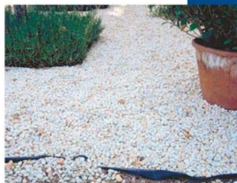
Géotextile sous les gravillons
