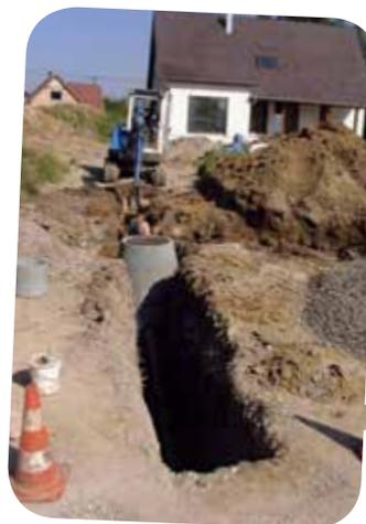
Raccordement au réseau d'assainissement
