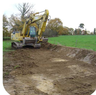
Talus à la pelle mécanique
